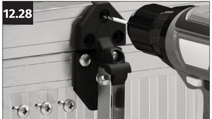
Bien que des vis auto-perceuses soient utilisées, nous recommandons de prépercer les trous avec un foret de 3,5 mm.
