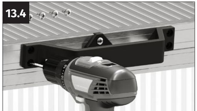
Bien que des vis autoforeuses soient utilisées, nous recommandons de pré-percer les trous avec un foret de 4 mm.
