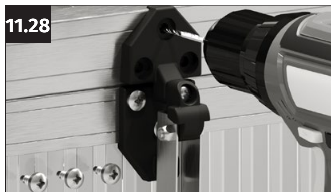
11.28 Mimo zastosowania wkrętów samowiercących zalecamy wstępne nawiercenie otworów wiertłem o średnicy 4 mm.
