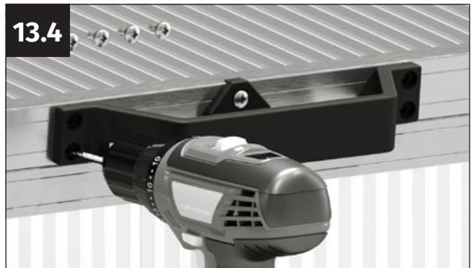
Bien que des vis autopercées soient utilisées, nous recommandons de prépercer les trous avec un foret de 3,5 mm.
