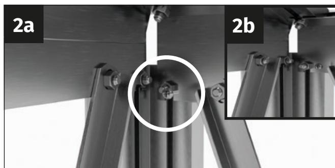
Continuez avec la gouttière et le profilé d'angle latéral. Vissez le profilé d'angle latéral et la gouttière avec la vis autoforeuse 4,8x13 mm.
