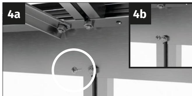
Continúa con el canalón y los refuerzos de pared. Atornillar el canalón y los refuerzos de pared con tornillos autoperforantes de 4,8 x 13 mm.
