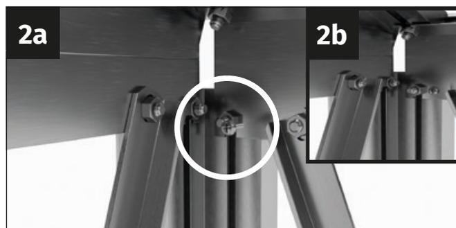
Continúa con el canalón y el perfil lateral angular. Atornilla el perfil lateral angular y el canalón con el tornillo taladrador de 4,8x13 mm.
