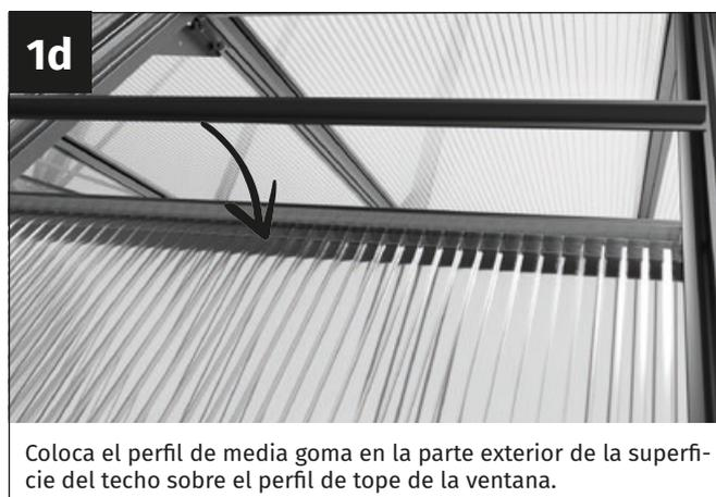
Coloca el perfil de media goma en la parte exterior de la superficie del techo sobre el perfil de tope de la ventana.
