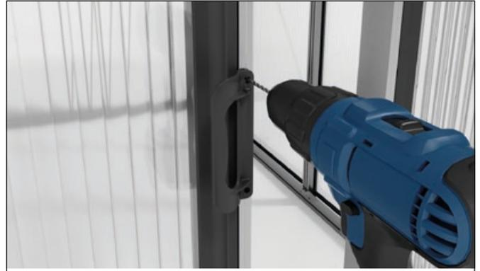
Empieza a montar las manillas exteriores taladrando los agujeros con una broca de 4 mm.
