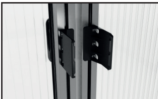
Verschrauben Sie die Türgriffe mit Bohrschrauben 4,8 x 13 mm.
