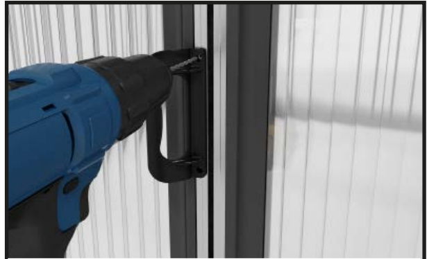
Start med de udvendige dørhåndtag. Bor huller med et 4 mm bor.
