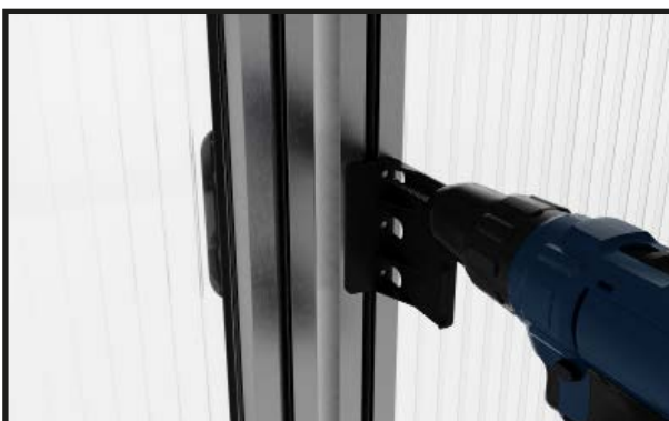
Monter nu de indvendige dørhåndtag. Bor huller med et 4 mm bor.
