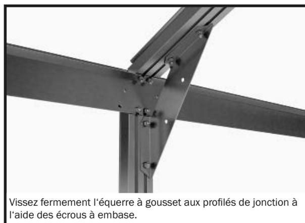
Vissez fermement l'équerre à gousset aux profilés de jonction à l'aide des écrous à embase.
