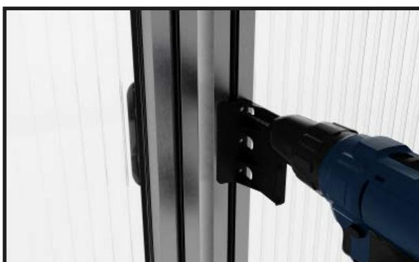
**Montez maintenant les poignées de porte intérieures.** Percez des trous avec une mèche de 4 mm.
