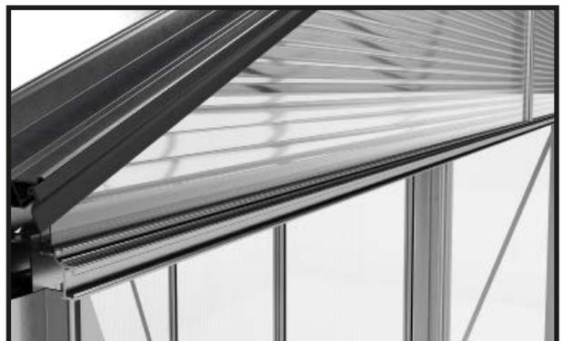
Montez les profilés simple en caoutchouc sur les profilés de toit pour maintenir la plaque sur le dessus du cadre.
