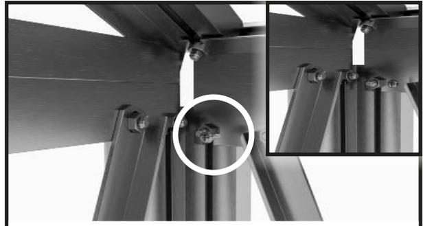
Continuez avec le profilé de gouttière et le profilé d'angle latéral. Vissez les deux avec la vis de perçage 4,8x13 mm.
