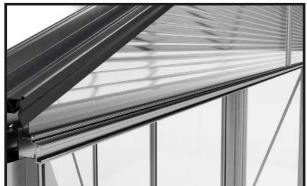
Montare le mezza guarnizioni in gomma sui profili angolari del tetto per tenere la lastra nella parte superiore del telaio.
