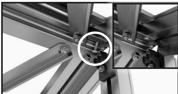
Continuare con il colmo e il profilo angolare del tetto. Avvitare il colmo e il profilo angolare del tetto con la vite perforante da 4,8x13 mm.
