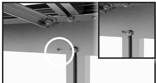
Continuare con la grondaia e i puntelli della parete. Avvitare la grondaia e i puntelli della parete con la vite perforante da 4,8x13 mm.
