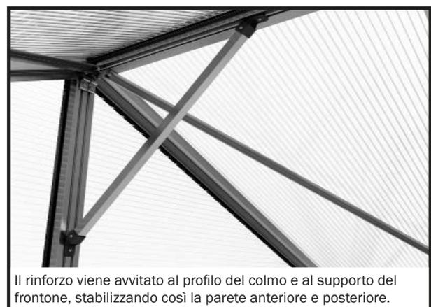
Il rinforzo viene avvitato al profilo del colmo e al supporto del frontone, stabilizzando così la parete anteriore e posteriore.
