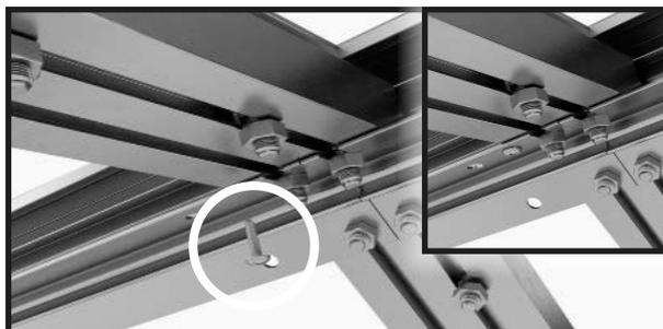
Continuare con il profilo di accoppiamento del tetto e il colmo. Avvitare il profilo di accoppiamento del tetto e il colmo con la vite perforante da 4,8x13 mm.
