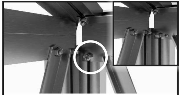
Continuare con la grondaia e i profili angolari laterali. Avvitare il profilo angolare laterale e la grondaia con la vite perforante da 4,8x13 mm.
