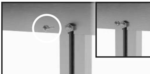
Continuare con il profilo d'ingresso della porta e il puntone trasversale. Avvitare il profilo di ingresso della porta e la traversa con la vite perforante da 4,8x13 mm.
