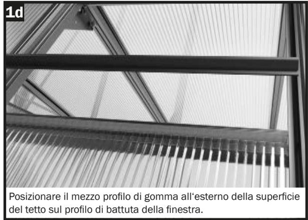
Posizionare il mezzo profilo di gomma all'esterno della superficie del tetto sul profilo di battuta della finestra.
