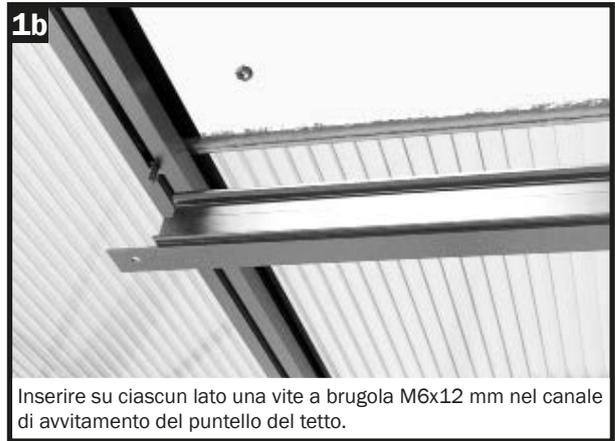
Inserire su ciascun lato una vite a brugola M6x12 mm nel canale di avvitamento del puntello del tetto.
