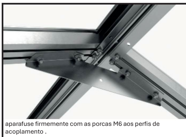
Aperte a chapa de junção com as porcas de flange com os perfis de acoplamento.
