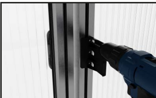
Montera nu de inre dörrhandtagen. Borra hål med en 4 mm borrhål.
