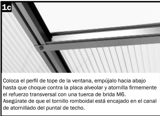
Coloca el perfil de tope de la ventana, empujalo hacia abajo hasta que choque contra la placa alveolar y atornilla firmemente el refuerzo transversal con una tuerca de brida M6. Asegúrate de que el tornillo romboidal está encajado en el canal de atornillado del puntal de techo.
