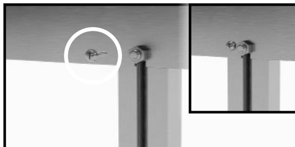
Continúa con el perfil de entrada de la puerta y el refuerzo transversal. Atornilla el perfil de entrada de la puerta y el travesaño con el tornillo perforador de 4,8x13 mm.
