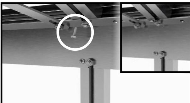
Continúa con el canalón y los puntales del techo. Atornilla el canalón y los puntales del techo con el tornillo perforador de 4,8x13 mm.
