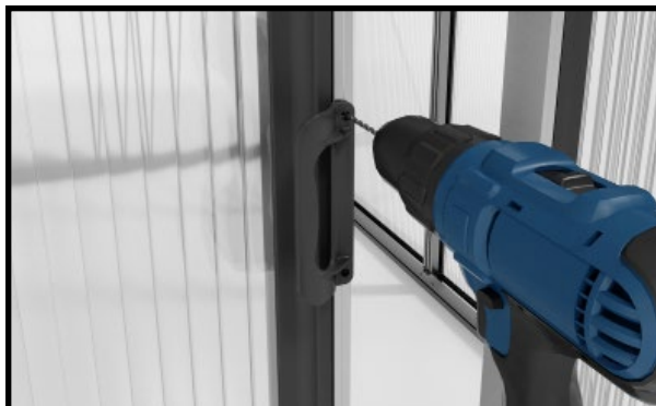
Iniziare con le maniglie esterne della porta. Praticare fori con un trapano da 4 mm.
