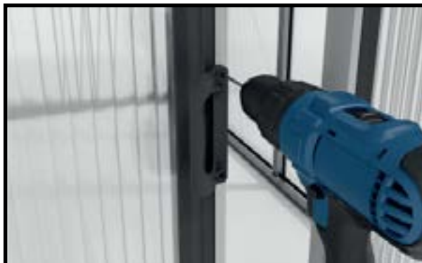
Begynn med de ytre dørhåndtakene. Bor hull med et 4 mm bor.
