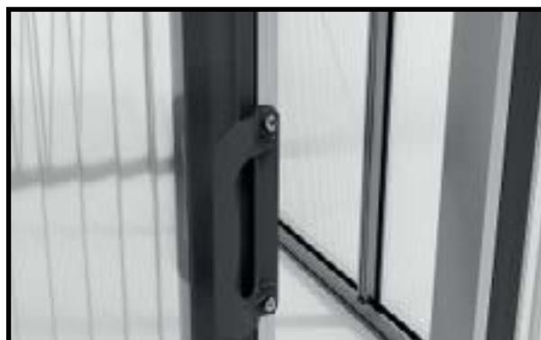
Skru dørhåndtaket med boreskruer 4,8 x 13 mm.
