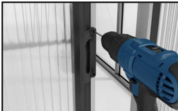
Start med de udvendige dørhåndtag. Bor huller med et 4 mm bor.
