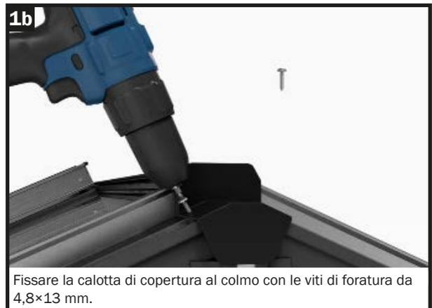
Fissare la calotta di copertura al colmo con le viti di foratura da 4,8x13 mm.
