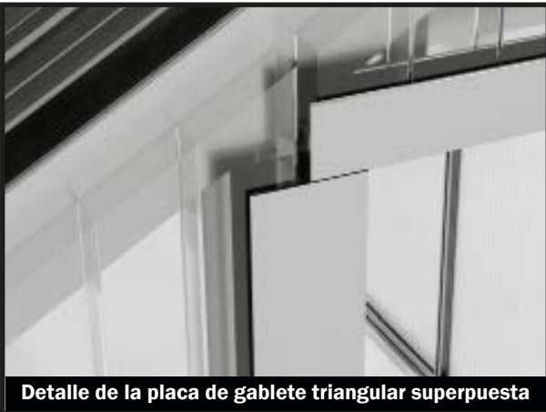
Coloca el perfil en U en la parte inferior de la placa de gablete triangular.
