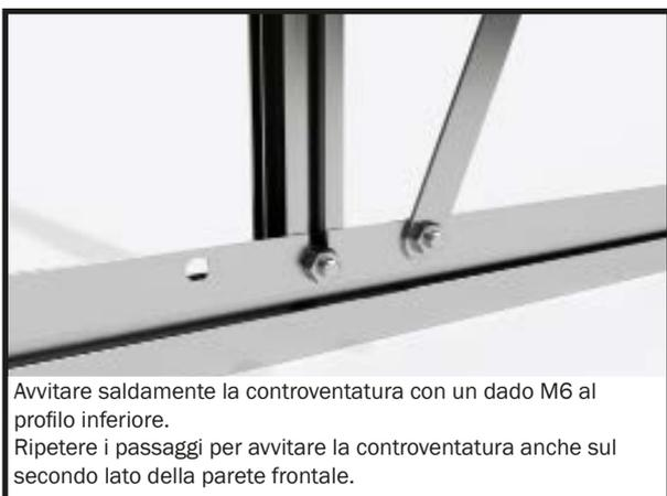
Avvitare saldamente la controventatura con un dado M6 al profilo inferiore.
