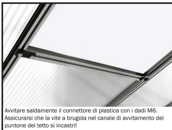
Avvitare saldamente il connettore di plastica con i dadi M6. Assicurarsi che la vite a brugola nel canale di avvitamento del puntone del tetto si incastrerà!
