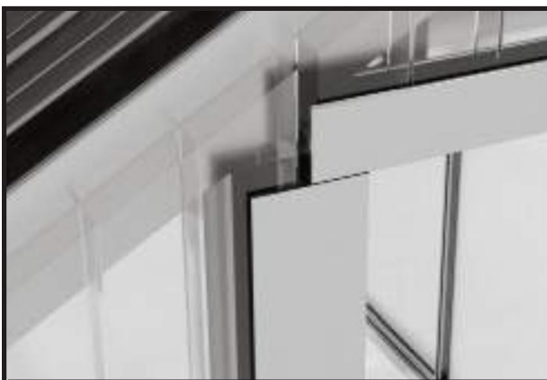
Detalj påmontert gaveltrekantplate
