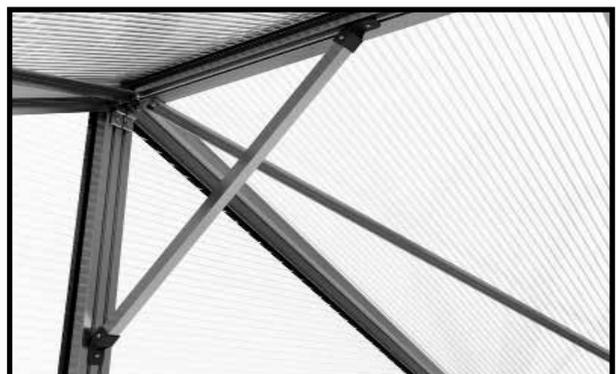
El refuerzo se atornilla en el perfil de la cumbrera y en el soporte del gablete para estabilizar la pared delantera y trasera.
