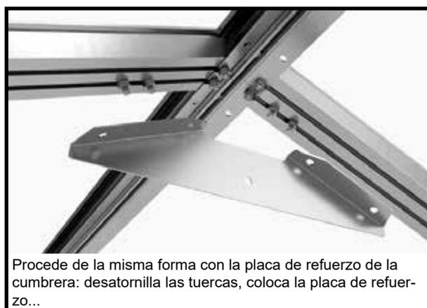
Procede de la misma forma con la placa de refuerzo de la cumbrera: desatornilla las tuercas, coloca la placa de refuerzo...
