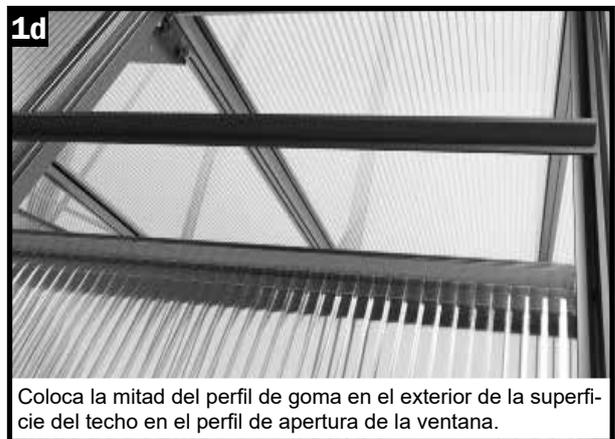
Coloca la mitad del perfil de goma en el exterior de la superficie del techo en el perfil de apertura de la ventana.
