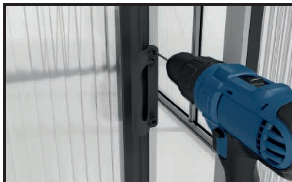
Iniziare con le maniglie esterne della porta. Praticare fori con un trapano da 4 mm.
