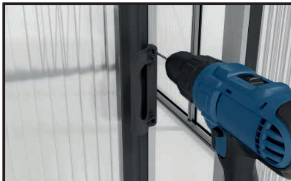
Begin met de buitenste deurgrepen. Boor gaten met een boor van 4 mm.
