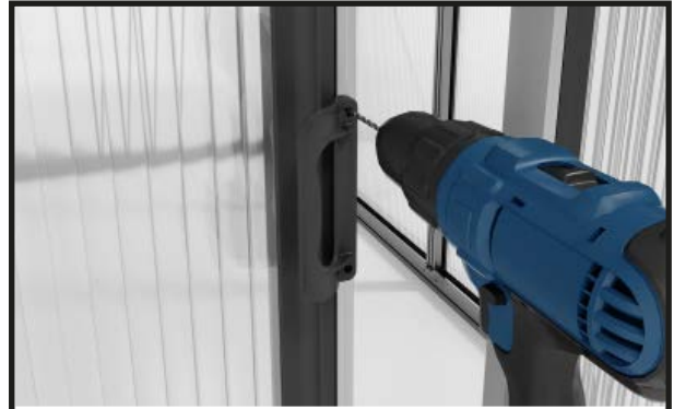
Empieza con los tiradores exteriores. Perfora orificios con una broca de 4 mm.
