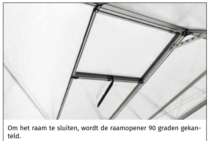
Schuif het vensterraam naar de vensteropening die is overgebleven bij het beglazen van het dakvlak.
