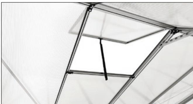
Para abrir la ventana, el soporte de la ventana se encaja en el perfil de tope inferior en la posición deseada con la muesca correspondiente (no hay equivalente en la guía de aluminio).
