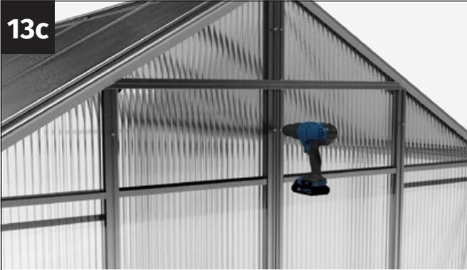
Atornilla firmemente los listones a los puntales de la pared trasera con tornillos de 3,9x13 mm.
