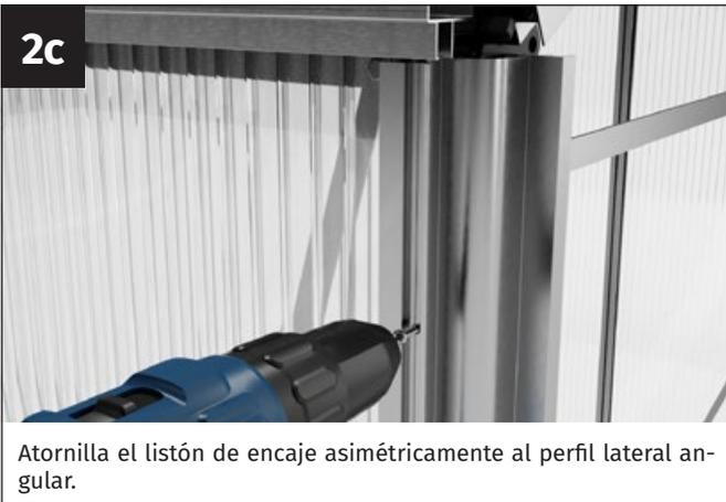
Atornilla el listón de encaje asimétricamente al perfil lateral angular.
