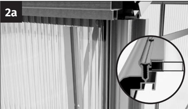
Para el perfil lateral angular, utiliza un listón de encaje asimétrico y un tornillo de chapa de 3,9x13 mm.
