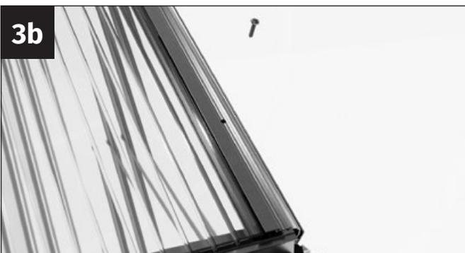
Coloca el listón de encaje asimétrico sobre el perfil de techo angular. NOTA: ¡El perfil de techo angular y el listón de encaje deben tener la misma longitud!
