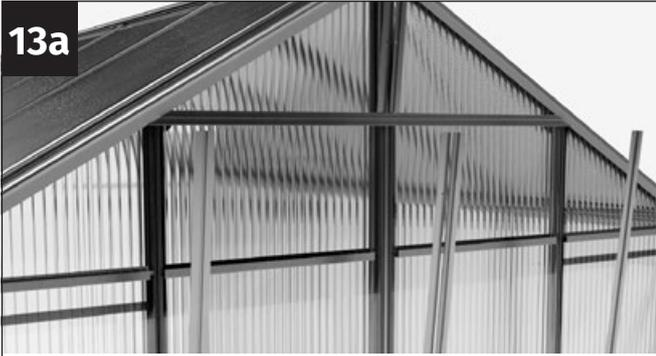
Coge los dos listones de encaje simétricos para los refuerzos de la pared trasera y los dos listones de encaje asimétricos para los perfiles de acoplamiento de la pared trasera.
