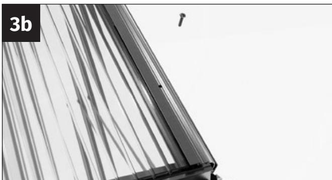
Placez la baguette de serrage de manière asymétrique sur le profilé de coin de toit. REMARQUE : le profilé de coin de toit et la baguette de serrage doivent avoir la même longueur !
