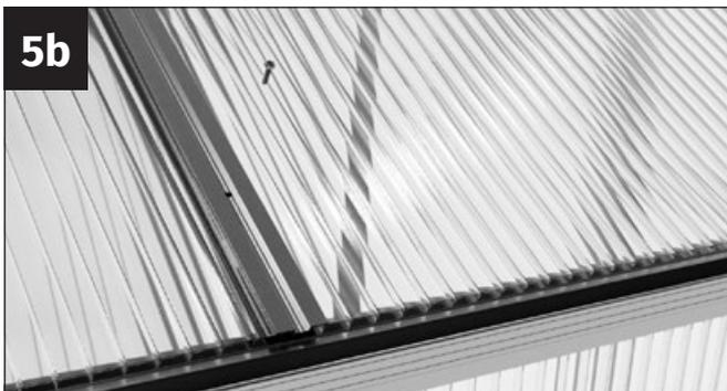
Placez la baguette de serrage de manière symétrique sur les entretoises du toit. REMARQUE : l'entretoise de toit et la baguette de serrage doivent avoir la même longueur !
