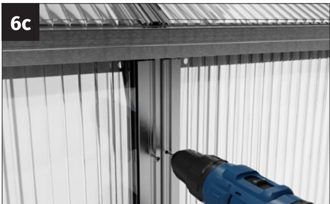
Schroef de klemstrip op het hoekprofiel.
