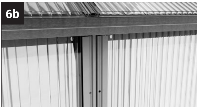
Plaats de klemstrip asymmetrisch op de koppelsteunen aan de zijwand. OPMERKING: Koppelschoor en klemstrip moeten even lang zijn!
