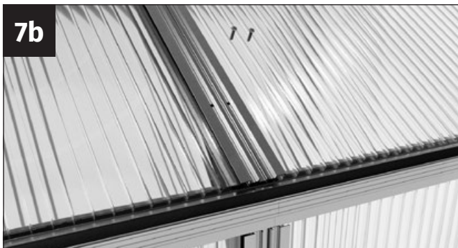
Plaats de klemstrip asymmetrisch op de koppelsteunen van het dak. OPMERKING: Koppelschoor en klemstrips moeten even lang zijn!
