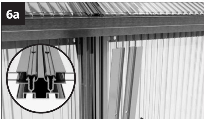
Gebruik voor de koppelschoor van de zijwand twee asymmetrische klemstrips en een plaatschroevendraaier van 3,9 x 13 mm.
