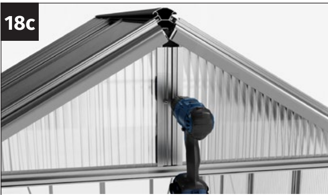
18c Skru glasslistene godt fast til takstøtten med 3,9 x 13 mm selvgjengende skruer.
