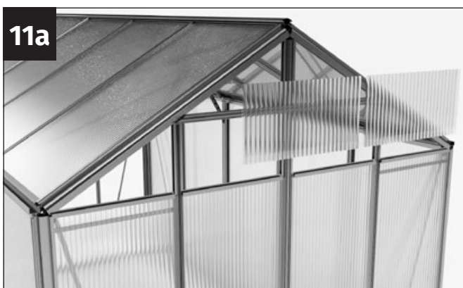
Bruk de to rektangulære platene til bakveggen.
