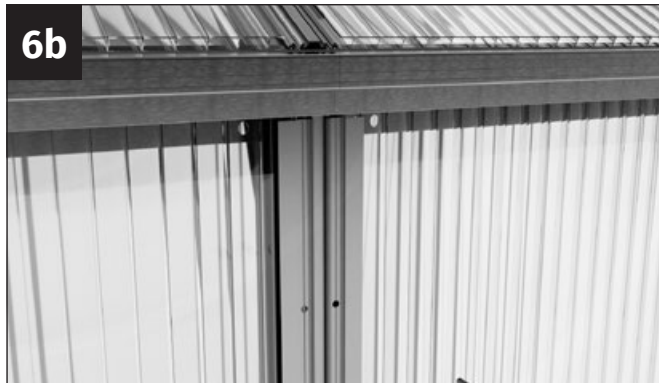
Placera klämlisten asymmetriskt på sidopanelens kopplingsstag. OBS: Kopplingsstaget och klämlisterna måste ha samma längd!
