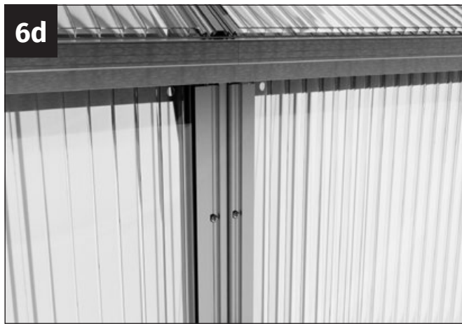
Placera klämlisten asymmetriskt på sidopanelens kopplingsstag. OBS: Kopplingsstaget och klämlisterna måste ha samma längd!
