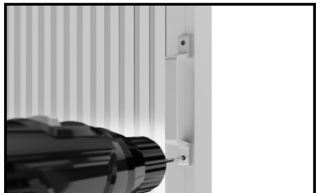
Bor huller med et 4 mm bor. Brug håndtaget som skabelon til hullerne.
