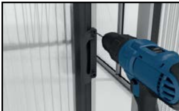
Begynn med de ytre dørhåndtakene. Bor hull med et 4 mm bor.
