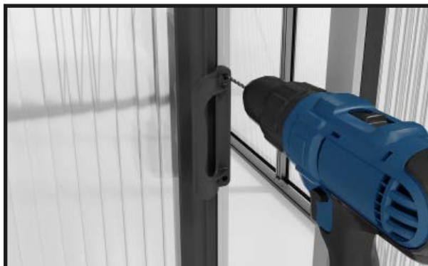
Należy zacząć od zewnętrznych klamek. Wywiercić otwory wiertłem 4 mm.
