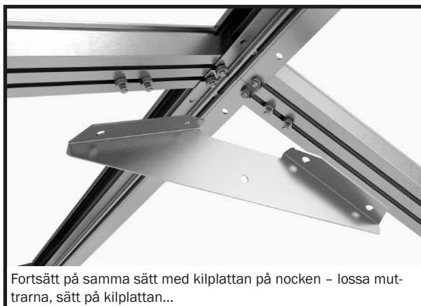
Ta bort muttrarna från skruvarna som används i kopplingsprofilerna, placera skruvarna i enlighet med hålen i kilplattan och sätt på den.
