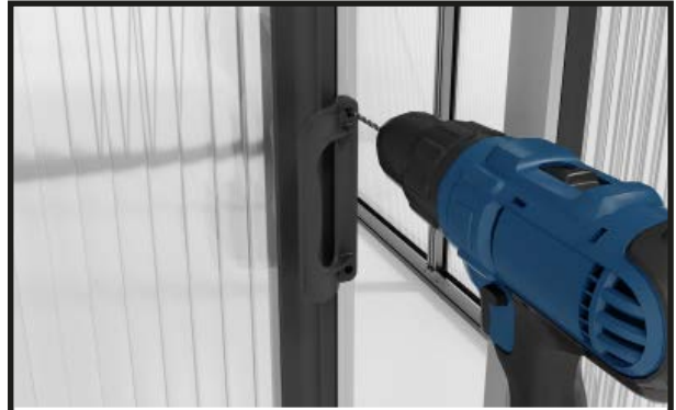
Börja med de yttre dörrhandtagen. Borra hål med en 4 mm borr.
