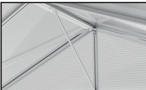
Die Versteifung wird am First und an der Giebelstütze verschraubt und stabilisiert so die Front- und Rückwand.
