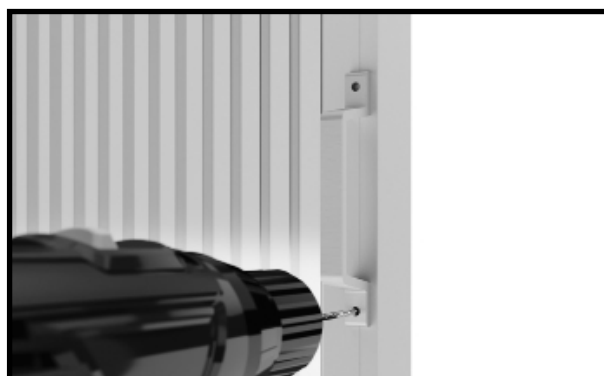
Bor huller med et 4 mm bor. Brug håndtaget som skabelon til hullerne.
