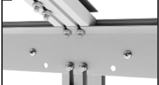
Introduce un tornillo M6x12 en el canal de atornillado y atornilla firmemente el perfil de acoplamiento al canalón.
