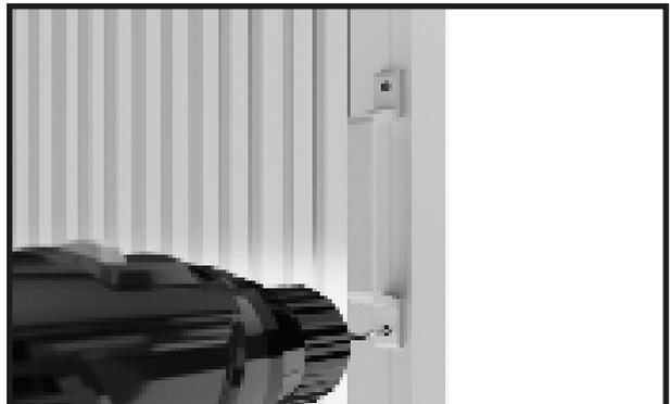
Perfora los orificios con una broca de 4 mm.
