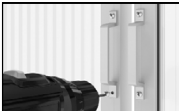
Fest dørhåndtakene med de selvborende skruene 4,8x13 mm
