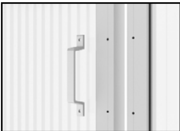
Klargjør dørhåndtakene og de selvborende skruene 4,8x13 mm.
