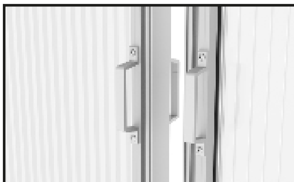
Montaż drzwi kończy się wraz z zamontowaniem klamek od wewnątrz i zewnątrz.
