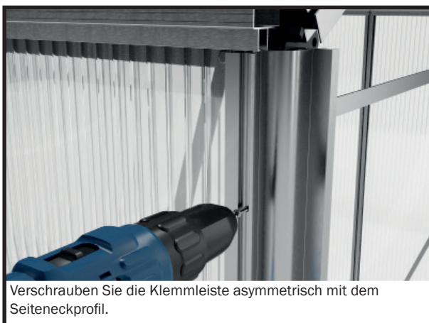
Für das Seiteneckprofil nehmen Sie eine Klemmleiste asymmetrisch und Blechtreiber 3,9x13 mm zur Hand.
