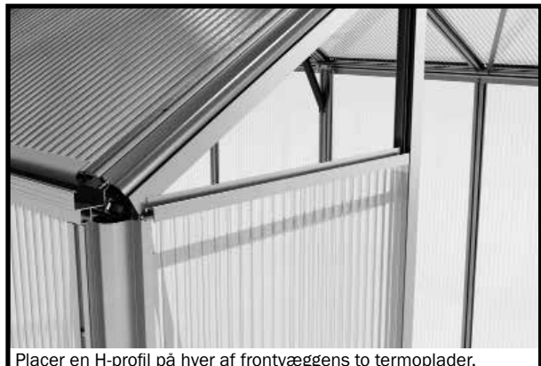
Placer en H-profil på hver af frontvæggens to termoplader.
