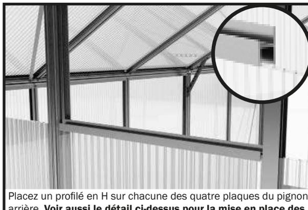
Placez un profilé en H sur chacune des quatre plaques du pignon arrière. **Voir aussi le détail ci-dessus pour la mise en place des profilés en H.**
