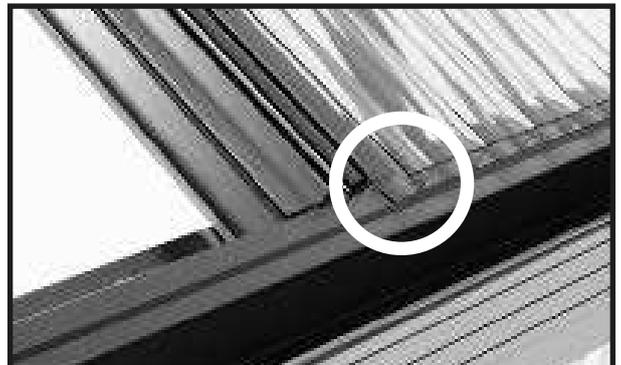
**Détail : plaque alvéolaire sur le profilé de gouttière.**
