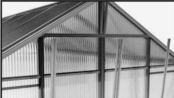
Prenez les deux baguettes de serrage symétriques pour les entretoises du pignon arrière ainsi que les deux baguettes de serrage asymétriques pour le profilé de jonction du pignon arrière.
