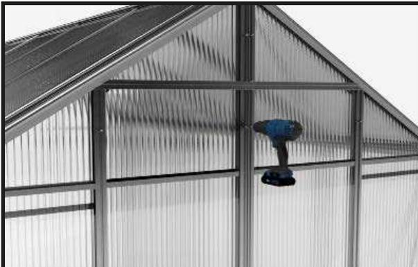
Vissez les baguettes fermement aux entretoises du pignon arrière avec des vis de 3,9x13 mm.
