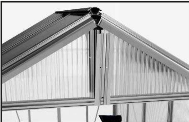
Prenez les deux baguettes de serrage asymétriques pour le support de toit du pignon avant.
