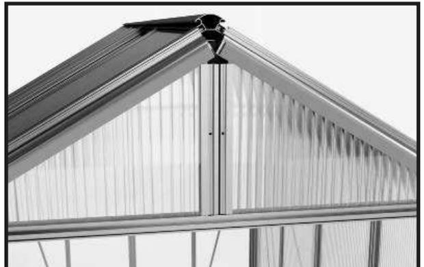
Placez les deux baguettes de serrage sur le support de toit.
