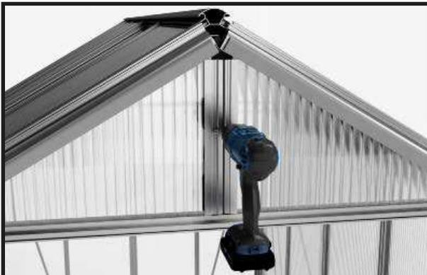
Vissez fermement les baguettes de serrage au support de toit avec des vis 3,9x13 mm.
