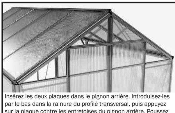
Insérez les deux plaques dans le pignon arrière. Introduisez-les par le bas dans la rainure du profilé transversal, puis appuyez sur la plaque contre les entretoises du pignon arrière. Poussez ensuite les plaques vers le bas, de sorte qu'elles reposent fermement sur les profilés en H.
