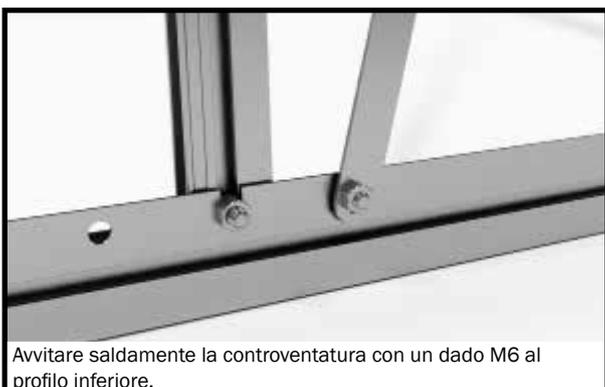
Avvitare saldamente la controventatura con un dado M6 al profilo inferiore.
