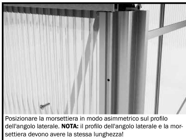
Posizionare la morsettiere in modo asimmetrico sul profilo dell'angolo laterale. **NOTA:** il profilo dell'angolo laterale e la morsettiere devono avere la stessa lunghezza!
