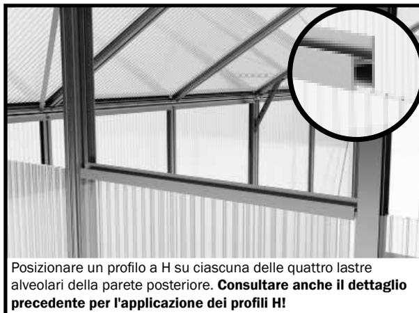
Posizionare un profilo a H su ciascuna delle quattro lastre alveolari della parete posteriore. **Consultare anche il dettaglio precedente per l'applicazione dei profili H!**
