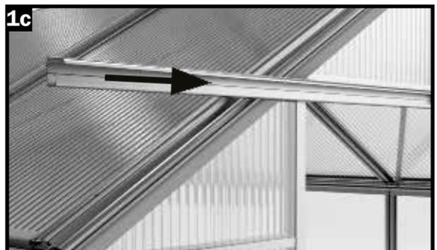
Inserire ora la seconda guida di scorrimento della porta nel puntone trasversale. Allineare le parti in modo che le due guide di scorrimento della porta si scontrino esattamente al centro.
