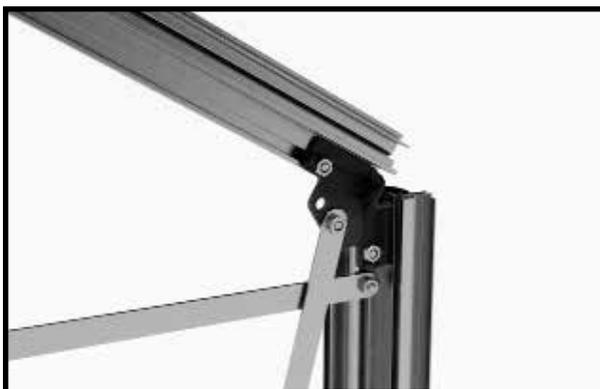
Avvitare la controventatura con un dado M6 al connettore angolare pressofuso di zinco.
