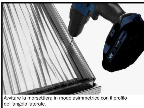
Avvitare la morsettiere in modo asimmetrico con il profilo dell'angolo laterale.
