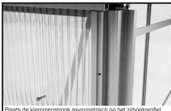
Plaats de klemmenstrook asymmetrisch op het zijhoekprofiel. OPMERKING: Zijhoekprofiel en klemmenstrook moeten dezelfde lengte hebben!
