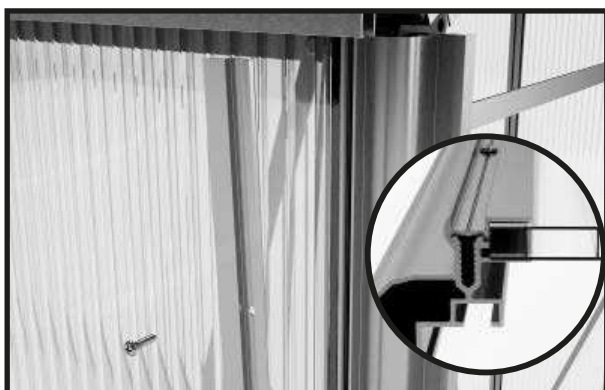
Voor het zijhoekprofiel neem je een asymmetrische klemmenstrook en plaatdriver 3,9x13 mm.
