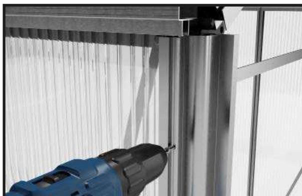
Schroef de klemmenstrook asymmetrisch vast aan het zijhoekprofiel.
