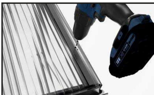
Schroef de klemmenstrook asymmetrisch vast aan het zijhoekprofiel.
