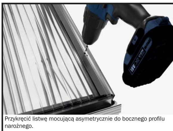
Do profilu dachowego należy zastosować asymetryczną listwę zaciskową i blachowkręt 3,9x13 mm.
