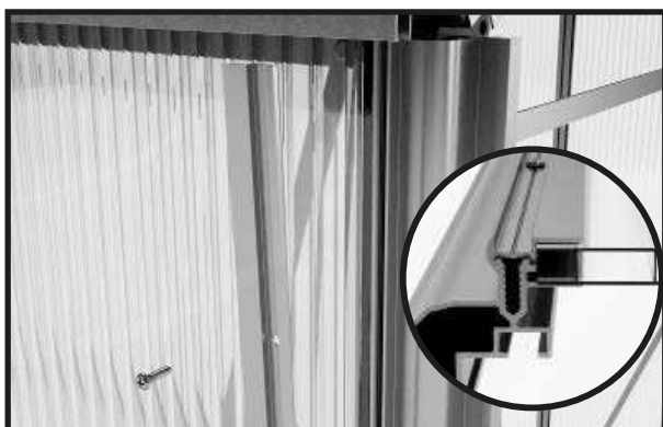
För sidohörnsprofilen, ta fram en asymmetrisk list och en 3,9x13 mm skruv.
