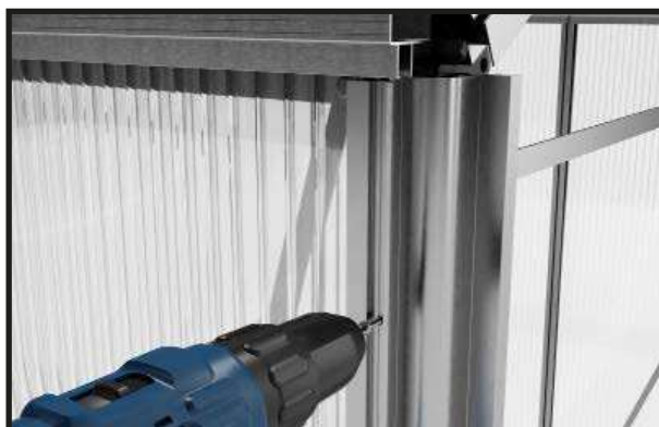
Skruva fast listen asymmetriskt till sidohörnsprofil.
