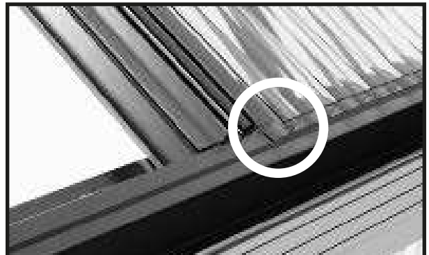
Detalj: Platta på positioneringskanten hos takrännan.
