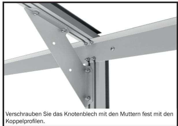
Verschrauben Sie das Knotenblech mit den Muttern fest mit den Koppelprofilen.
