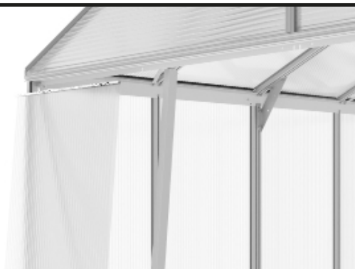
Ta bort dörrrens profil från frontväggen och sätt in plattan.
