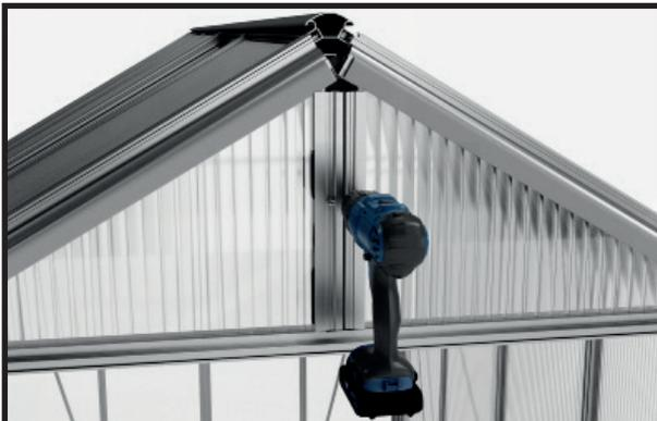
Verschrauben Sie die Klemmleisten mit Bohrschrauben 3,9 x 13 mm fest mit der Dachstütze.
