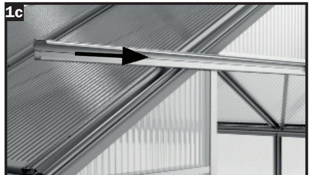
Führen Sie nun die zweite Türlaufschiene in die Querstrebe ein. Richten Sie die Teile so aus, dass die beiden Türlaufschienen exakt mittig zusammenstoßen.
