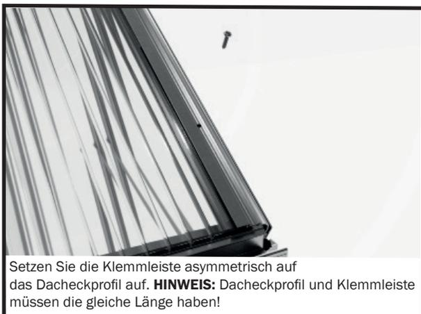
Setzen Sie die Klemmleiste asymmetrisch auf das Dacheckprofil auf. **HINWEIS:** Dacheckprofil und Klemmleiste müssen die gleiche Länge haben!
