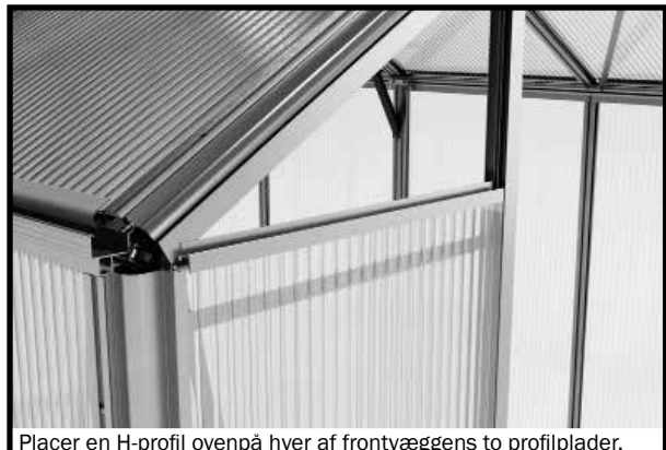
Placer en H-profil ovenpå hver af frontvæggens to profilplader.
